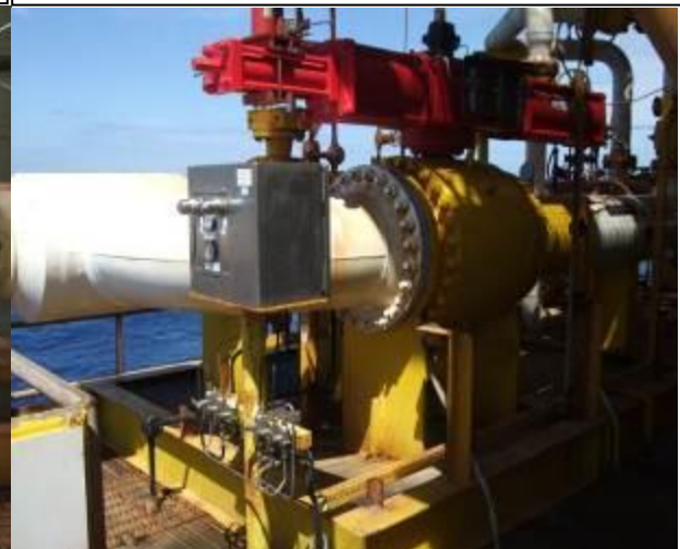
Fig. 6. Válvula de SDV con actuador neumático de simple acción de retorno por resorte con bomba hidráulica para apertura con tablero de control neumático para cierre de emergencia a través del monitoreo de la presión del gasoducto de entrada de gas combustible a Akal-B perforación. Cabe mencionar que esta válvula SDV no cuenta con los instrumentos de presión en voto 2003 para el Sistema SPPE de la plataforma PP-Ek-A.
