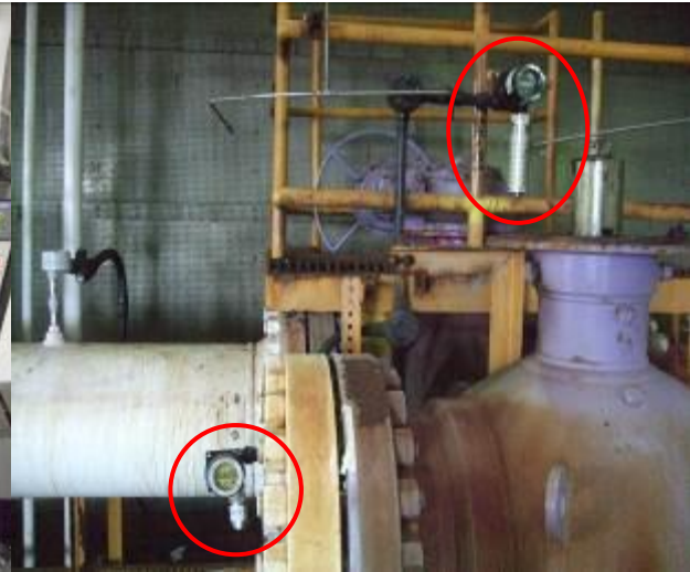
Fig. 16. Ubicación de los detectores de Gas toxico y gas combustible instalados en las trampas existente Mca. Det tronics. El contratista debe considerar esta marca de detectores en su propuesta para garantizar la compatibilidad y la correcta operación de estos detectores con el sistema de gas y fuego existente en la Plataforma PP-Ek-A.
