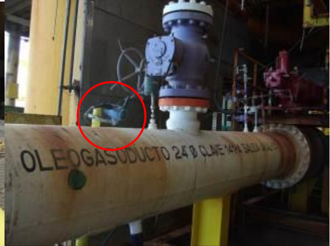
Fig. 8. Transmisor indicador de temperatura Inalámbrico con protocolo Smart Wireless monitoreados en el Sistema PI Process en la Plataforma PP-Ek-A.
