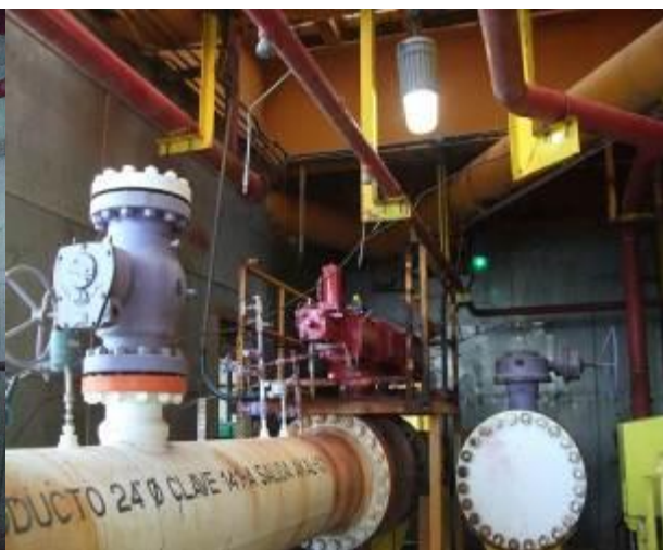
Fig. 18. Red de aspersión de agua contra incendio en la trampa de diablo de oleogasoducto de salida a Akal-C1 existente en la Plataforma PP-Ek-A. Esta se encuentra disponible operando manualmente y a través de su red neumática de tapón fusible.
