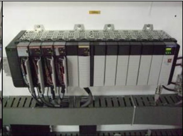
Fig. 4. Disponibilidad en Slot para instalar módulos de I/O en chasis CHR02 del Sistema de Fuego y Gas de la PP-Ek-A.
