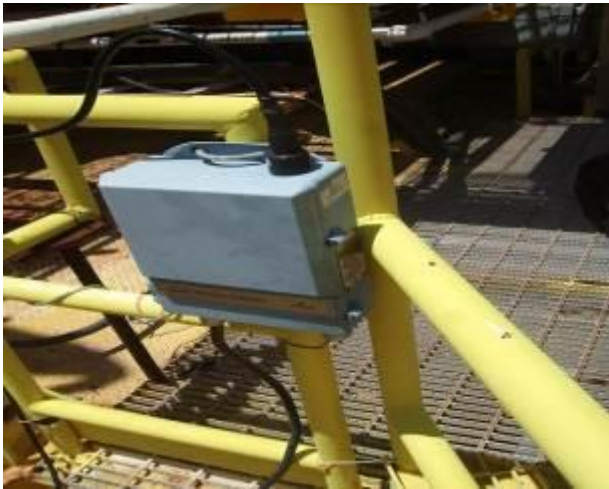
Fig. 7. Gateway existente con protocolo Smart Wireless para concentrar la información de los instrumentos inalámbricos en campo hacia la UPR Servidor de Proceso mediante comunicación Modbus RTU/ TCP IP. Los datos de estos instrumentos inalámbricos existentes en la plataforma PP-Ek-A son monitoreados en el Sistema PI Process a través de este equipo en campo.
