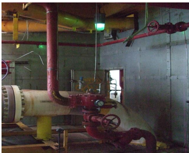
Fig. 17. Válvula Diluvio en Angulo Mca. Viking Serie E1 sin solenoide eléctrico, ni instrumentación instalada en la red neumática de tapón fusible. Esta se encuentra disponible en Trampa de diablo del olegasoducto de salida a Akal-C1.
