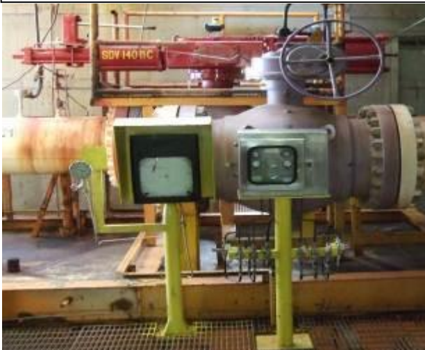
Fig. 5. Válvula de SDV con actuador neumático de simple acción de retorno por resorte con bomba hidráulica para apertura con tablero de control neumático para cierre de emergencia a través del monitoreo de la presión del oleogasoducto de salida a Akal-C1. Cabe mencionar que esta válvula SDV no cuenta con los instrumentos de presión en voto 2003 para el Sistema SPPE de la plataforma PP-Ek-A.
