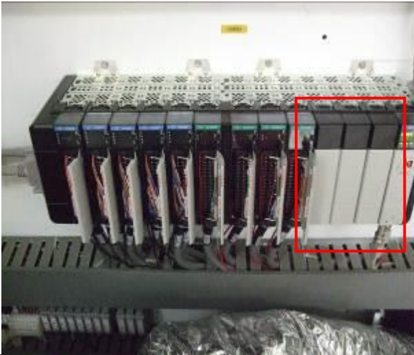
Fig. 15. El PLC redundante Micrologix de AB del Sistema de Fuego y Gas cuenta con slots disponibles en su chasis para instalar y configurar módulos de I/O para las señales de los detectores de gas y fuego e instrumentación del sistema de aspersión de agua contra incendio del proyecto.
