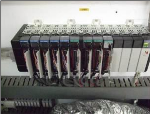
Fig. 3. Disponibilidad en Slot para instalar módulos de I/O en chasis CHR01 del Sistema de Fuego y Gas de la PP-Ek-A.
